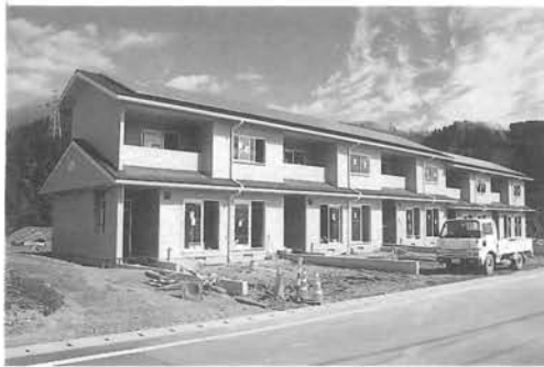
建設中の町営住宅
