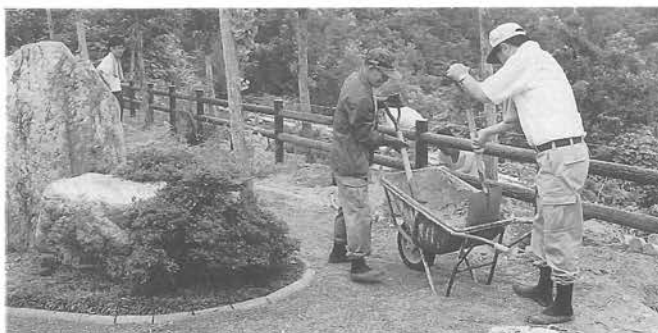
フェンスの取り付け
