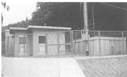
完成した配水地
