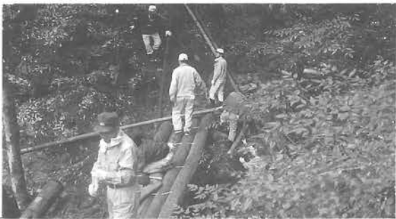
轟滝周辺公園整備
