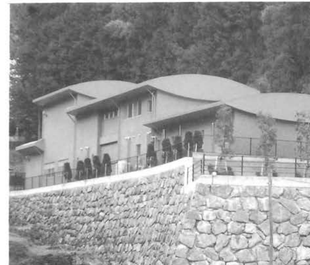
完成した斎場「静浄苑」
