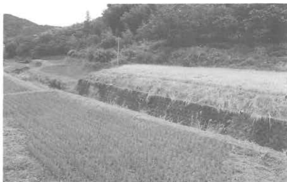
改修された大谷川護岸
