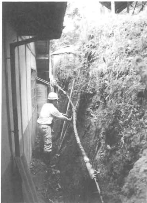
がけ崩れ危険箇所の調査
