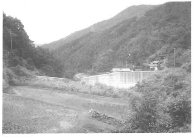
小藪に完成した砂防ダム
