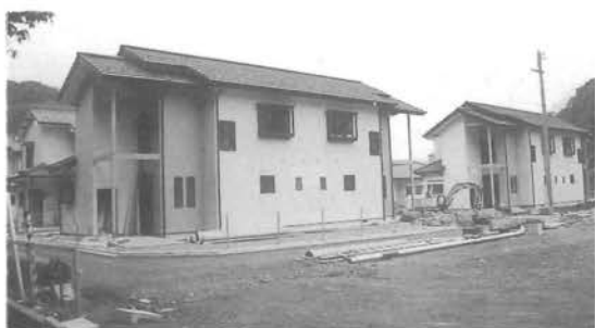
建設中の住宅
