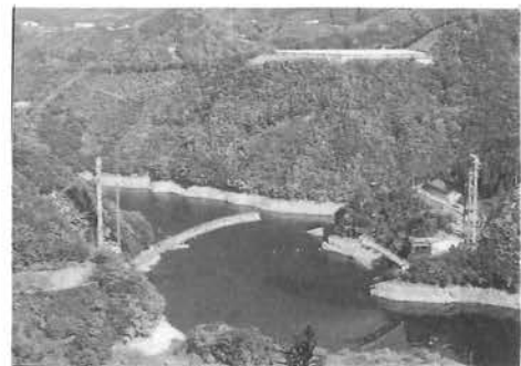
着々と工事が進む鹿野川湖大橋 (後方は省エネルギーモデル温室)
