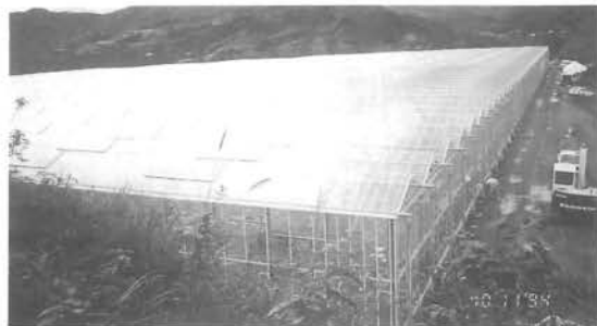
着々と工事が進められている省エネルギーモデル温室
