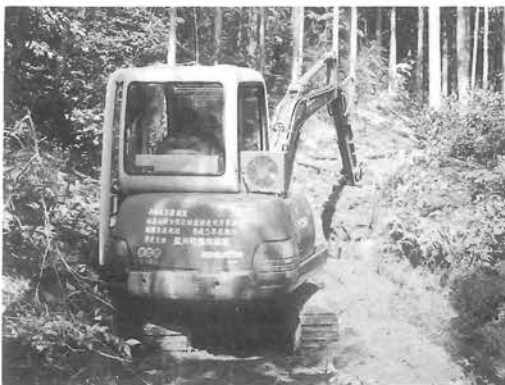
林内作業路の開設により作業能率を上げる
