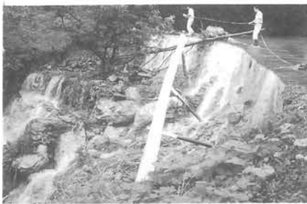
平成5年7月台風5号の時の災害 (小倉地区)
