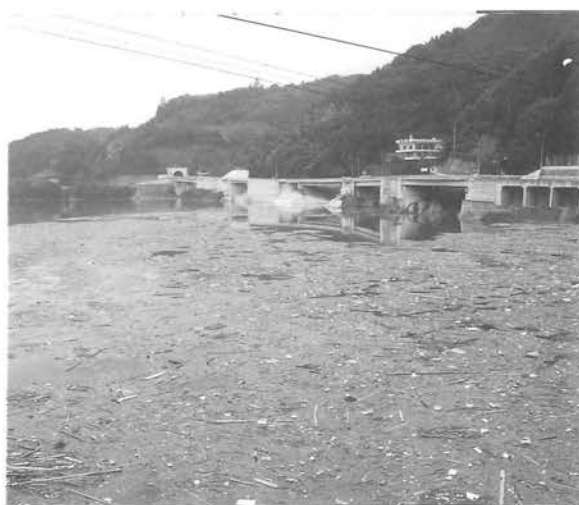
鹿野川ダムの流木
