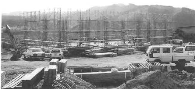
11月完成を目指して建設が進む風の博物館
