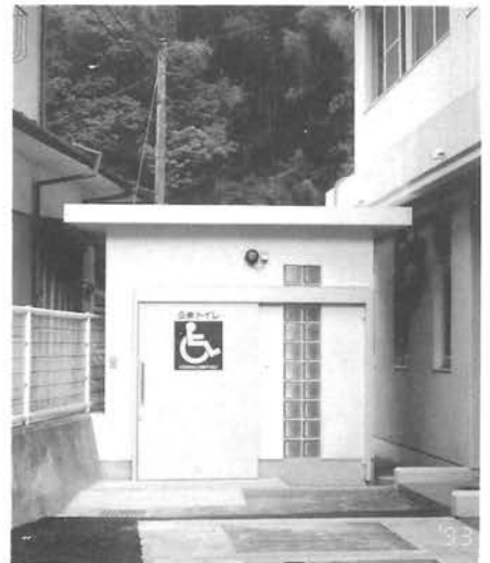
完成した身障者用トイレ
