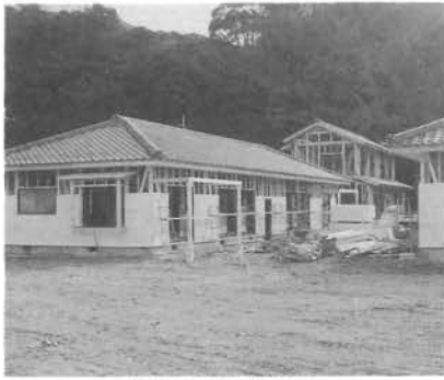
建設中の町営住宅
