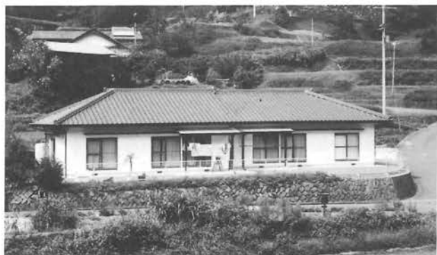
完成した町営住宅(大谷)
