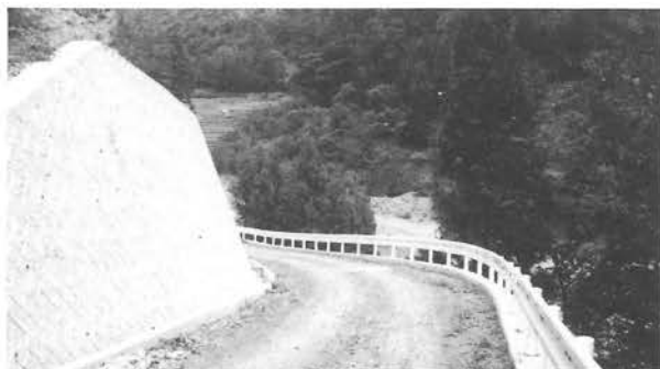
整備が進む菟の尾地区農道
