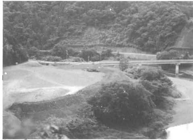
埋立て工事が完了した福祉ゾーン(道野尾)
