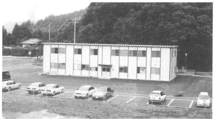
大駄場に完成した河辺川ダム工事事務所
