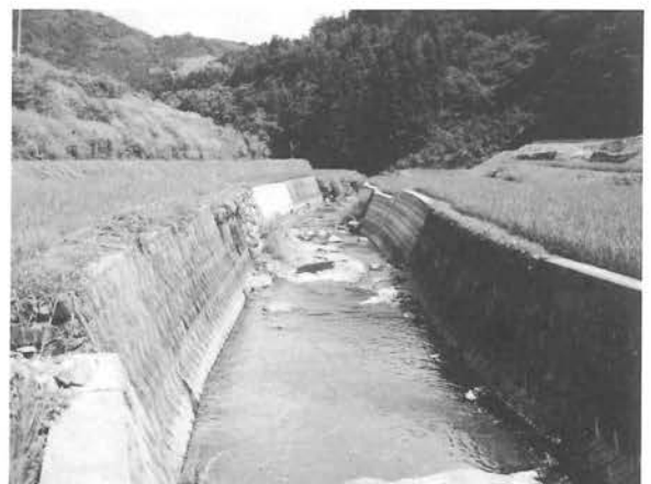
災害がおこるたびに護岸がコンクリートブロックに(大谷川)
