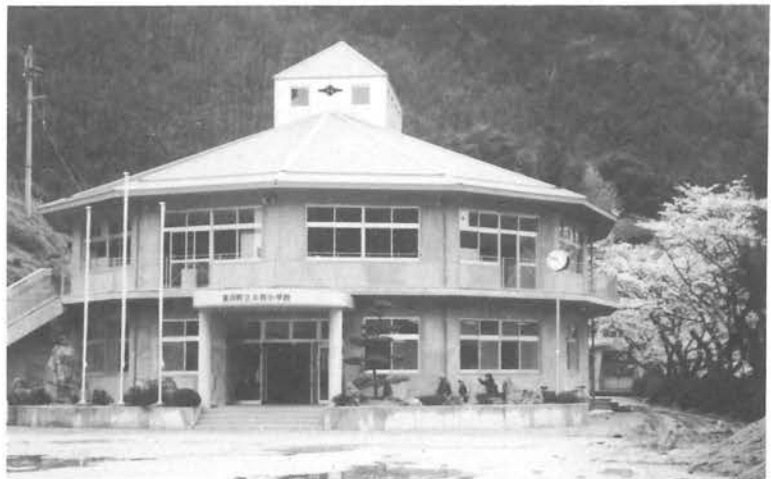
完成した大谷小学校
