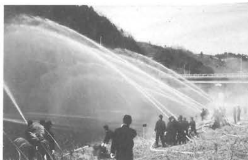
中学校前の河原で一斉放水
