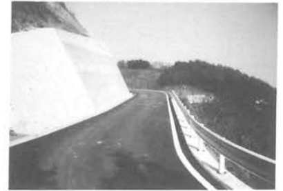
竣工した上中野地区
