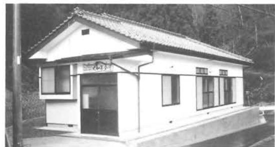
完成した大和集会所
