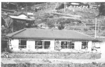
現在建設中の広常団地
