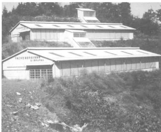
畜産環境対策事業（糞尿処理施設2棟）
