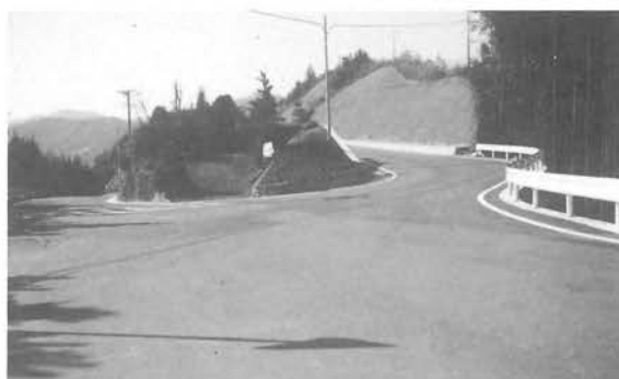
町道津の内～道野尾線（改良）
