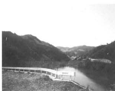
鹿野川湖大橋の架橋附近
