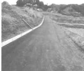
竣工したシミズ地区農道
