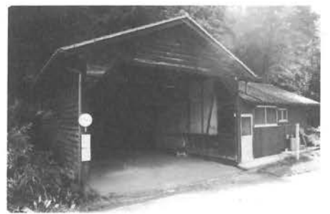
利用されなくなったJR白石車庫
