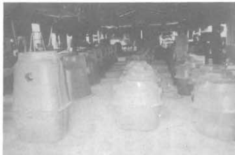
つぎつぎ組立られる浄化槽
