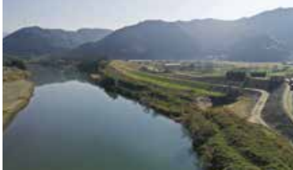
伊州子地区 暫定堤防施工状況
