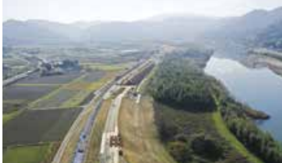
八多喜地区 暫定堤防施工状況
