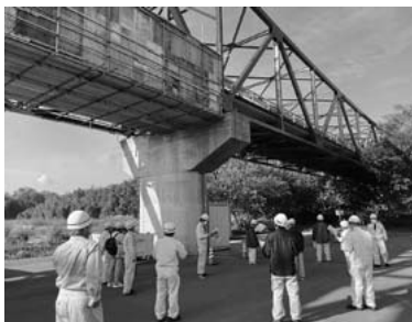
新畑の前橋修繕工事
