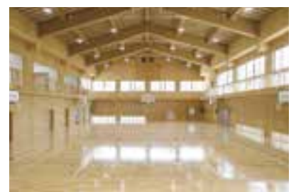
完成した栗津小学校屋内運動場
