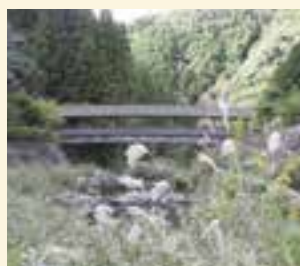
龍王橋（浪漫八橋）
