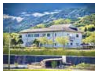
肱南浄化センター
