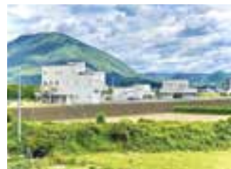
肱北浄化センター
