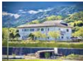
肱南浄化センター
