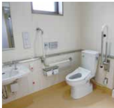
多目的トイレ
