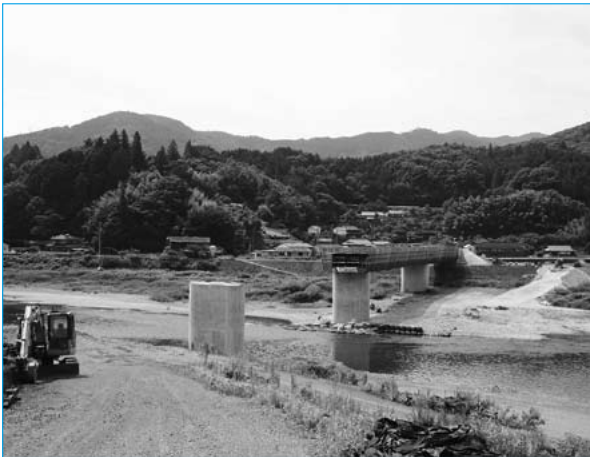
工事中の大成橋
