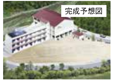
敷地を嵩上げて肱川中学校の施設整備を行っています。
