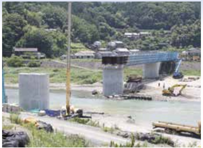
令和4年3月の完成を目指して工事が進む大成橋 おこなる
