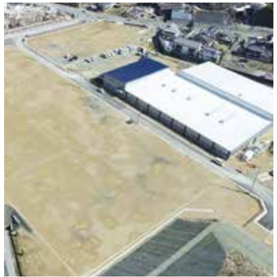
県農業試験場蚕業支場跡地に完成した工業用地
