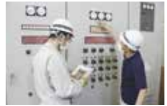
堀の内雨水ポンプ場は、出水期前に点検動作確認を行っています。
