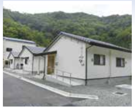
災害公営住宅（下鹿野川団地）木造平屋建て10棟が完成しました。
