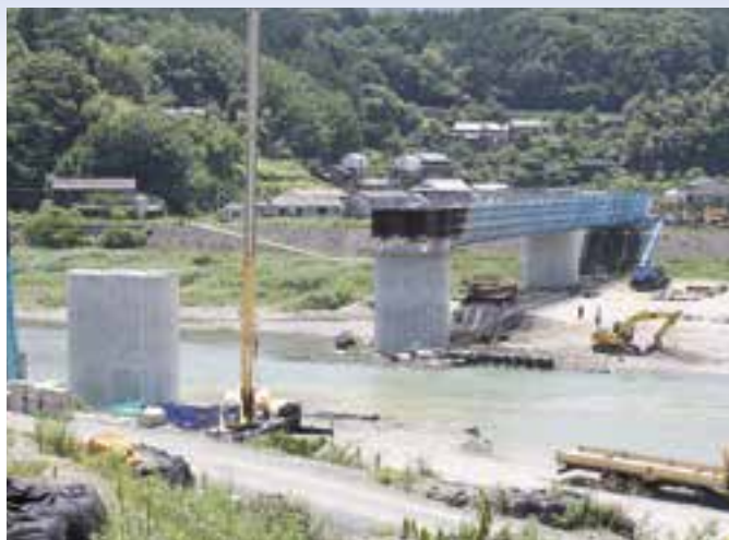
令和4年3月の完成を目指して工事が進む大成橋
