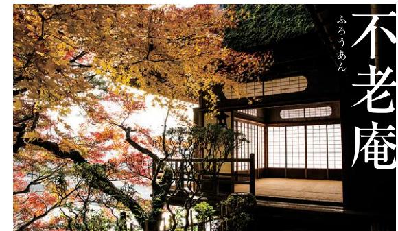
臥龍淵を足下に見る崖の上に舞台造りに建てた数寄屋造りのこの庵は、そのものを舟と見立てる。穹窿状竹網代張り一枚天井は、川面の月光反射を狙った巧妙な趣向。床は二間幅の仙台松一枚板を用い、二間の曲がり竹を落とし掛けに、違い棚をつけない簡潔さ。入り口縁続きに大徳寺菫路庵に見るような素朴な意匠の茶室（三畳台目）があり、生きた楳の木を使った「捨て柱」を基準に建てられている。
