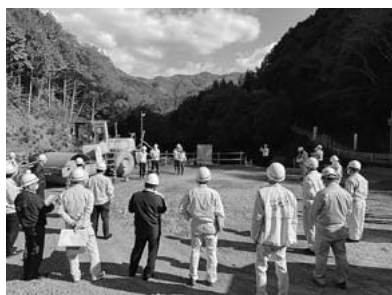
下敷水地区残土処理場
