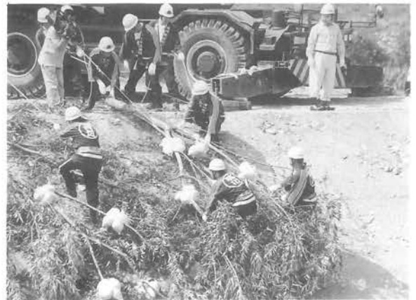
水防工法による木流し工
