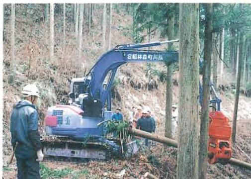
(バックホーでの作業風景)
