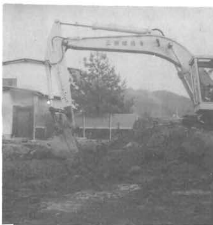
工事中の駐車場
