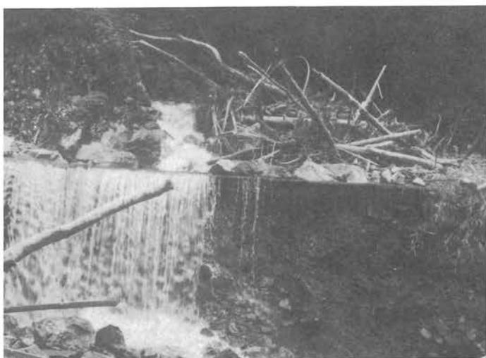
発生した災害 62. 7. 18
