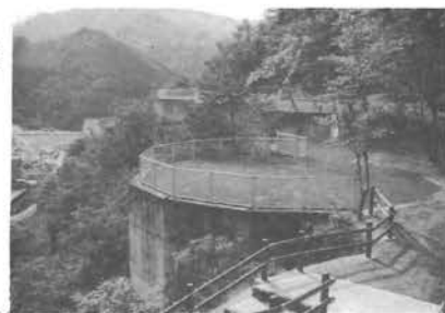
完成したダムサイト広場
