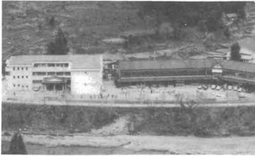
旧校舎横に完成した中野小新校舎
