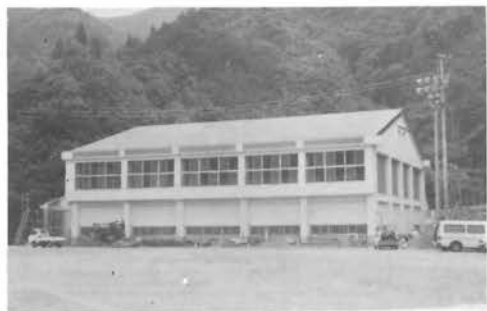
完成したトレーニングセンター
