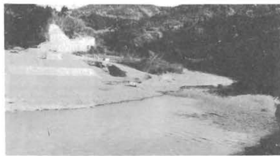
道野尾橋は右岸の橋台がすでに完成
