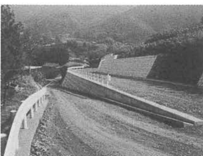
予子林と野村町(坂石)を結ぶため現在工事中の汗嵐線
