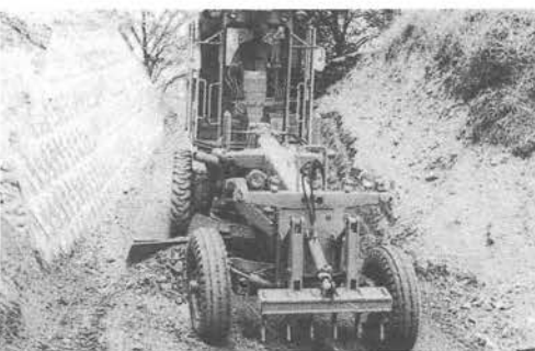
グレーダによる路面整備
