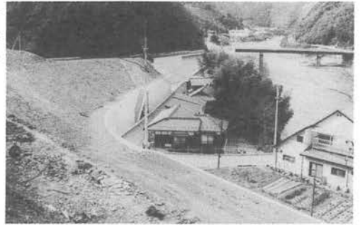
国道改良工事が進む下石丸地区
