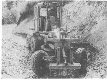
町道を整備するグレーダー
