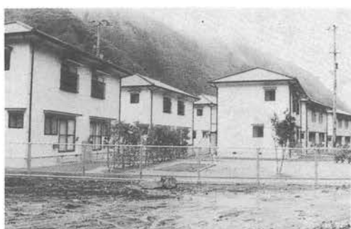
8棟16世帯が入居している中野団地
