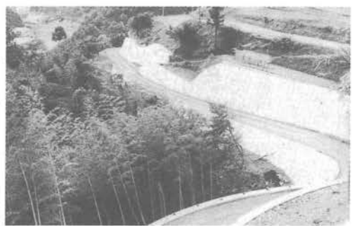
工事が進められている上中野地区道路改良工事
