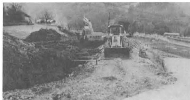
県営農免農道 道野尾線新設工事
