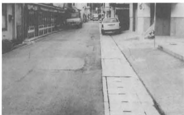
鹿野川簡易下水道工事
