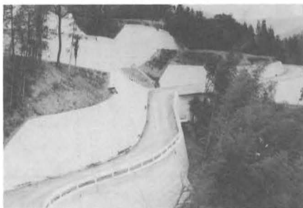
地域改善事業・上中野地区道路改良舗装工事 事業量902.0m・幅員4.0m・事業費168,862千円
