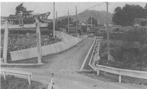
舗装された町道大駄場線
